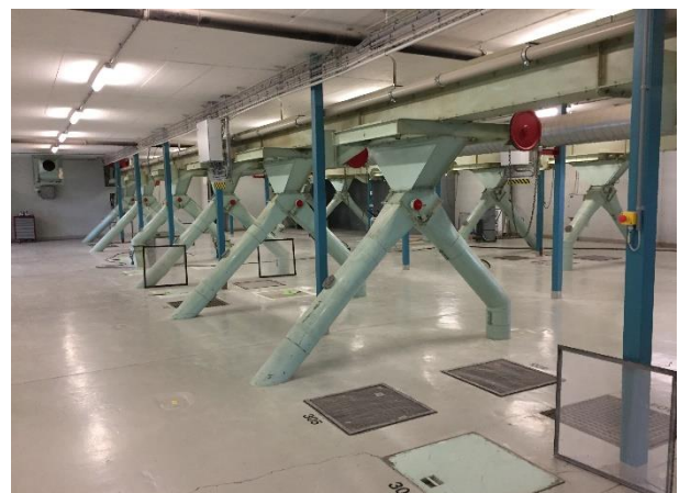
Abbildung 6: Blick in den Siloboden
