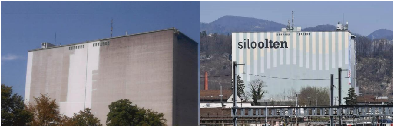
Abbildung 10: Vor der Sanierung der Aussenhülle und der Fassadengestaltung (links) und nachher (rechts).
