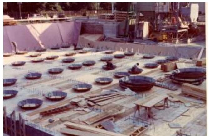
Abbildung 4: Fundament des Erweiterungsbaus 1974
