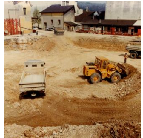
Abbildung 1: Aushub des Silo Olten 1971
