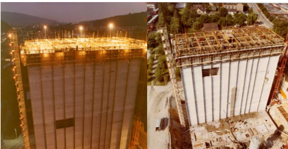
Abbildung 2: Es wird Tag und Nacht gearbeitet, so dass der Bau schnell fortschreitet
