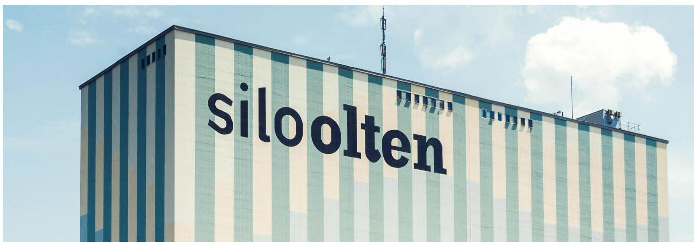
Le silo d'Olten joue un rôle clé pour assurer la sécurité de l'approvisionnement en Suisse. Il sera entièrement rénové d'ici 2026. Photo: fenaco GOF
