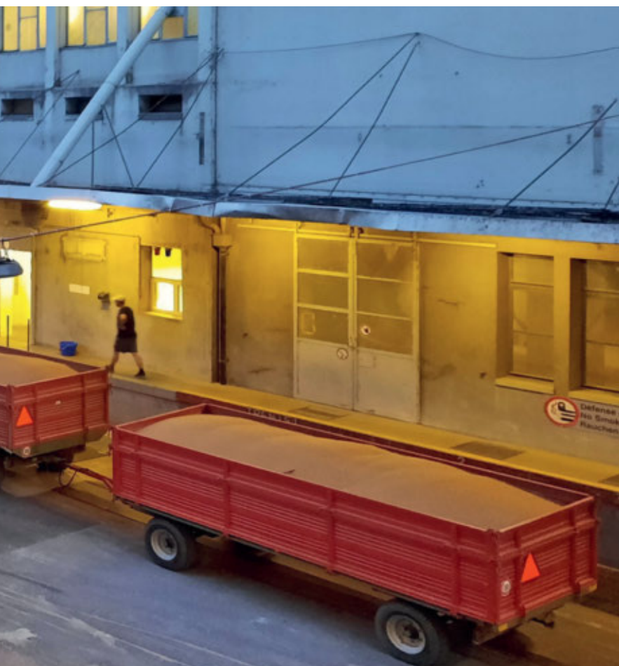
Die Getreidesammelstelle Cossonay-Penthalaz (VD) verfügt über eine jährliche Sammelmenge von rund 16 500 t und eine Lagerkapazität von 45 000 m 3 . Sie ist eine von rund 100 Sammelstellen, die im System Maxi der fenaco-LANDI Gruppe integriert sind.
